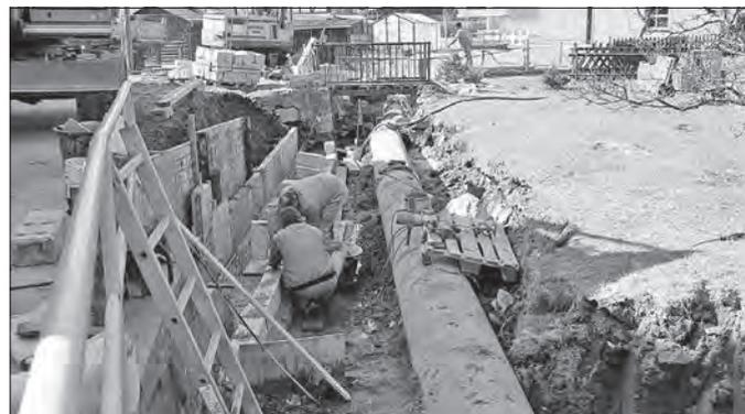
Die Firma Sturm arbeitet seit Ende März an der schadhaften Stützmauer der Lohe. Dabei wird auch die alte Steindeckerbrücke abgerissen und ersetzt.
