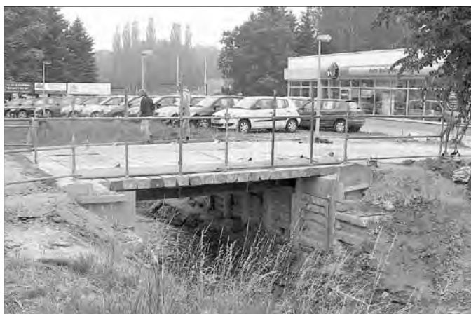
Behelfsbrücke am Seifenweg
