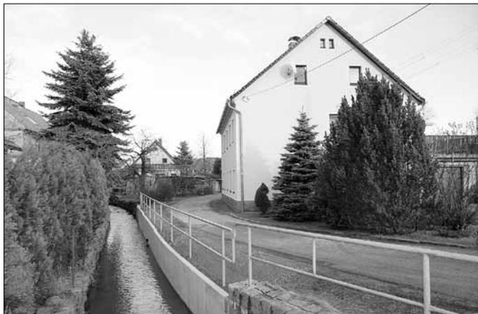
Bei diesem im Bild dargestellten Abschnitt der Lohe im Ortsteil Berthelsdorf wurden Hochwasserschäden an der straßenbegleitenden Stützwand beseitigt. Aufgrund der bauoffenen Wit-
