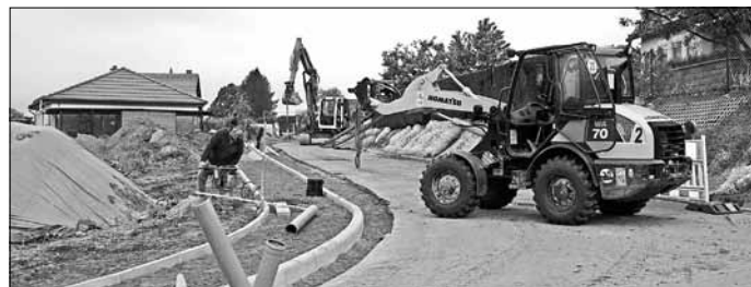
Ausbau des Fußwegs an der Straße „Am Hohwald“
