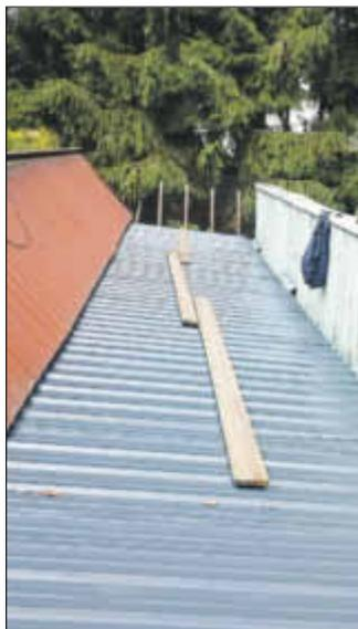
Am 4. und 5. September 2015 wurde bei einem Arbeitseinsatz auf dem Schießstand in Polenz das marode Vordach in Richtung der Schießbahnen erneuert. Dabei bauten die Mitglieder die alte Dachdeckung aus Bitumenwellplatten aus und ersetzten diese durch eine neue Blechtrapezeindeckung.
