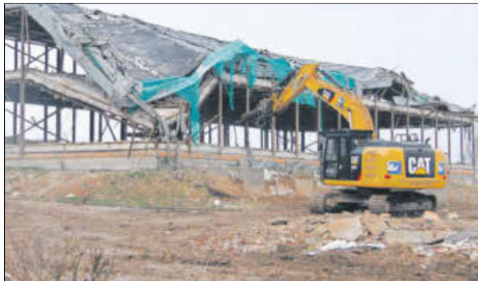
Abbruch des letzten ehemaligen Wohnheims im Gebiet Kirschallee am 6. April 2016
