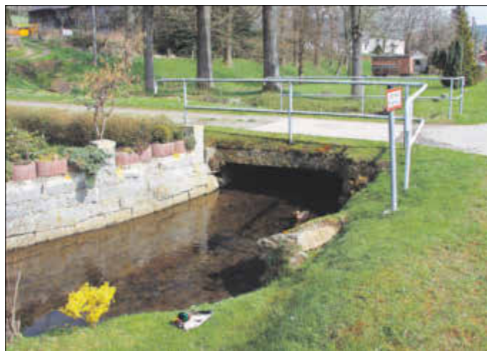
Ab 2. Mai beginnen die Bauarbeiten an dieser Brücke im Ortsteil Niederrottendorf
