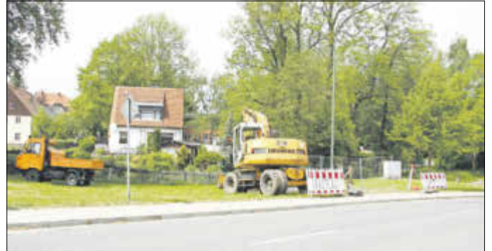
Vorbereitende Baumaßnahmen für den neuen Fahrgastunterstand durch die Firma Krause
