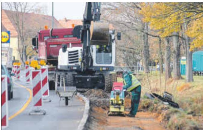
Einbau des Frostschutzes in den Gehweg, Foto: W. Thalheim
