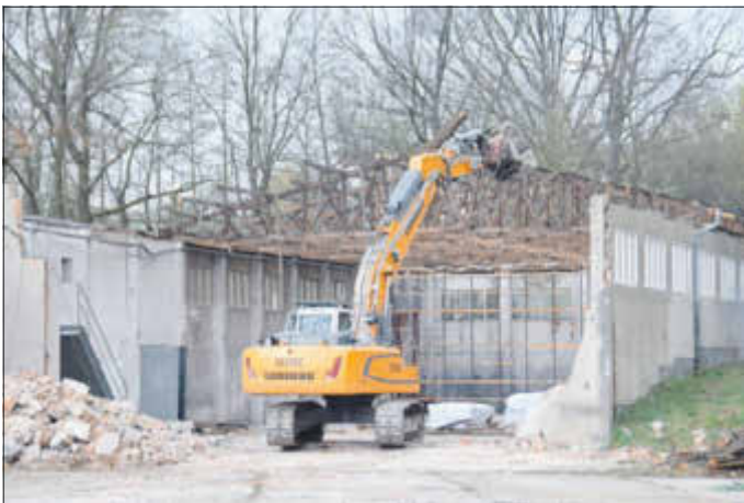
Abrissarbeiten am 8. April 2019, Foto: Werner Thalheim
