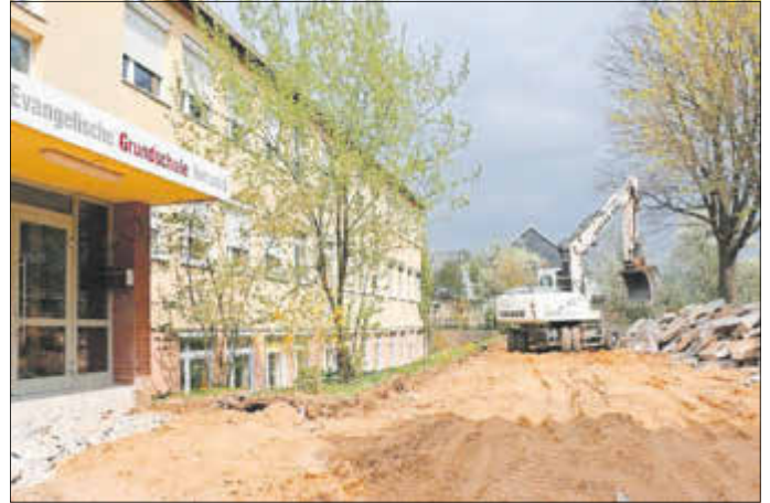
Entfernen der maroden Betonfläche am Eingangsbereich der Schule
