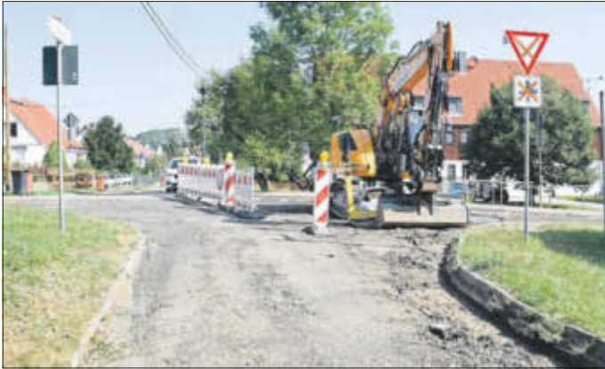
Ausbauarbeiten der Cunnersdorfer Straße, Foto: Werner Thalheim
