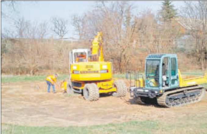
Erste Aushubarbeiten für die Löschwasserzisterne am 2. April 2019
