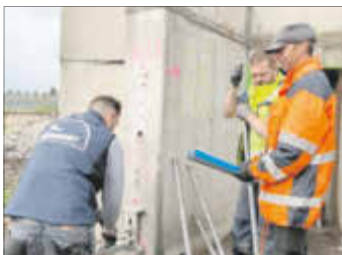
Vorbereitung der Sprengung, das Subunternehmen Bau-Diamant Szymanski beim Bohren der Sprenglöcher, v. l. Geschäftsführer Daniel Szymanski mit Mitarbeiter Maik Raddatz und Sprengstoff-experte Oliver Marks von der TVF ALTWERT Sprengtechnik GmbH
