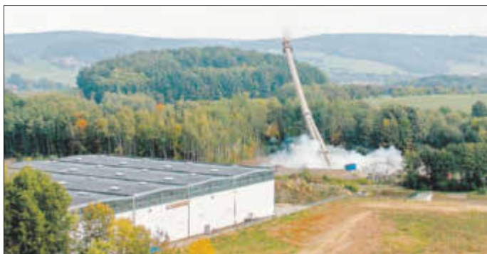
Sprengung des Schornsteins
