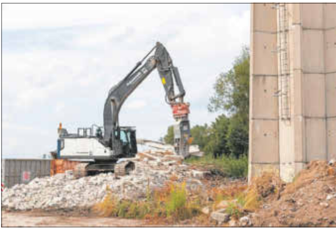
Die Gebäude um den Schornstein wurden im Juli fast komplett niedergelegt
