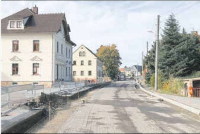
Abgefräste Fahrbahn mit neuem Bord am 18. Oktober 2019
