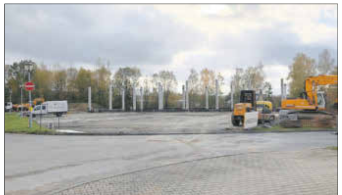
Bau der neuen Zweigniederlassung des Unternehmens Metallbau Löser GmbH & Co. KG
