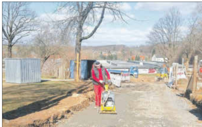
Arbeiten am Tunnelweg am 13. März 2019
