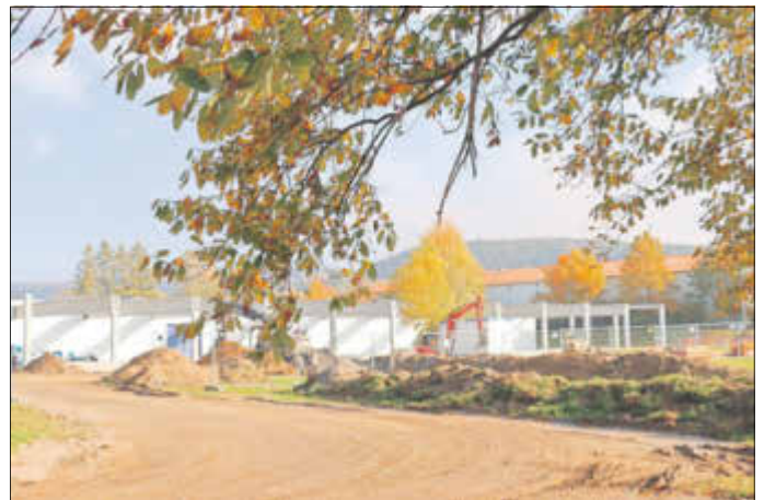
Arbeiten am neuen Anbau der WTK Elektronik GmbH Anfang November 2019
