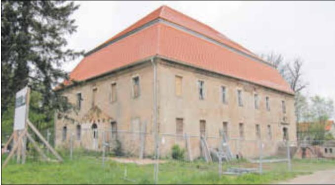
Herrenhaus Oberottendorf nach der Dachinstandsetzung
