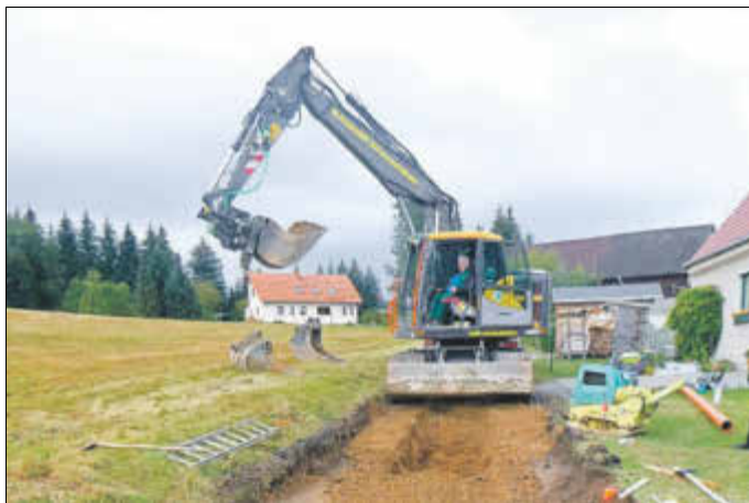
Baggerarbeiten an der Talstraße am 7. Oktober 2020
