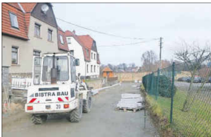
Setzen der Borde am 10. November 2021
