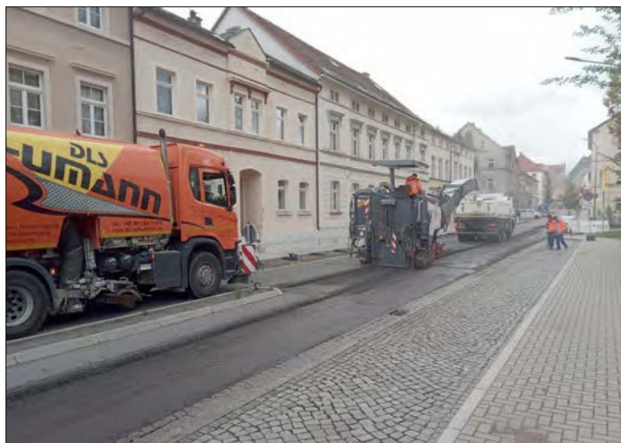
Beginn der Decklagensanierung mit dem Abfräsen des Bitumenbelags am 2. Juli 2024
