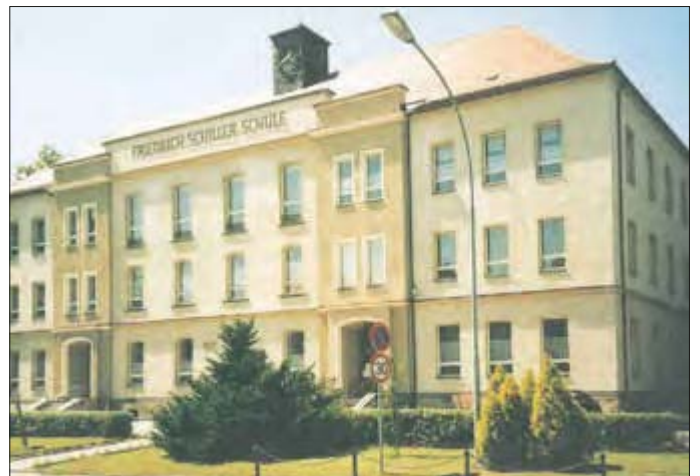
Die sanierte Schule im Jahr 1999
