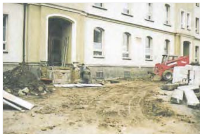
Während der Sanierungsarbeiten
