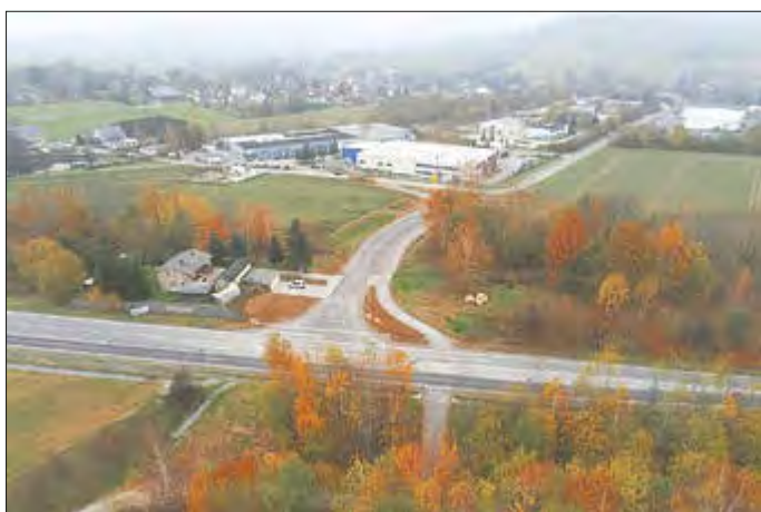
Baustelle S 156 mit Abbiegespur am 6. November 2024, Foto: Enrico Bartsch
