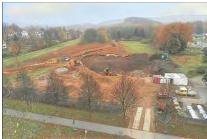
Blick auf die Baustelle am 6. November 2024, Foto: Enrico Bartsch
