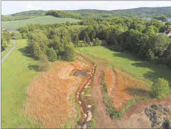
Blick auf die Baustelle im Sommer 2025, Foto: Enrico Bartsch
