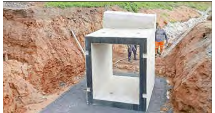
Herstellung eines Ersatzdurchlasses
