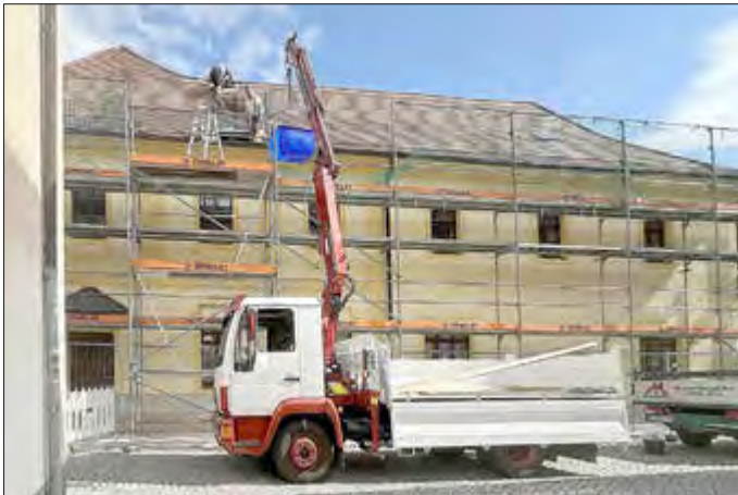
Beim Aufstellen des Gerüsts am 10. September 2025 für die Dacharbeiten
