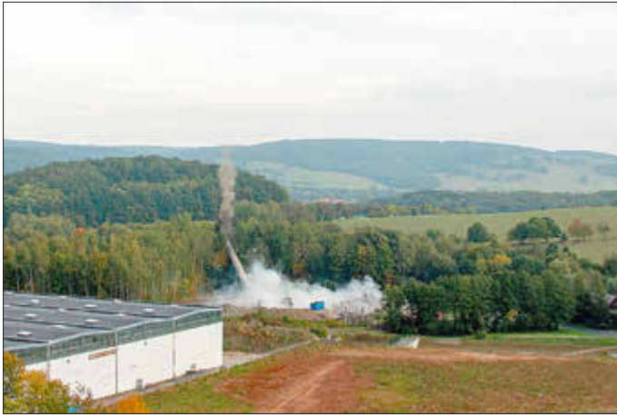
Sprengung des Schornsteins am 24. September 2019
