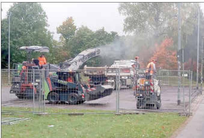
Abfräsen des Bolzplatzes am 7. Oktober 2025
