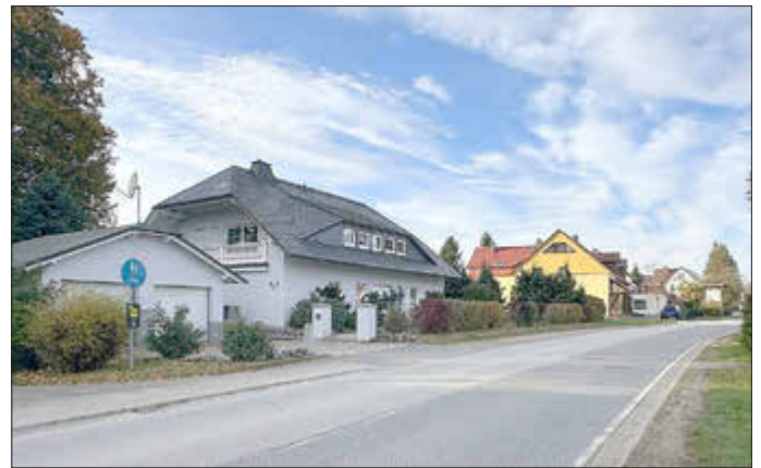
Geplanter Gehwegbereich im Ortsteil Oberottendorf, nach der Bushaltestelle Richtung Oberdorf, bis zum bereits vorhandenen Gehweg
