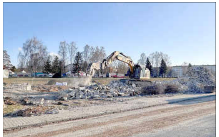
Rückbau des Wohnblocks Mitte März 2026
