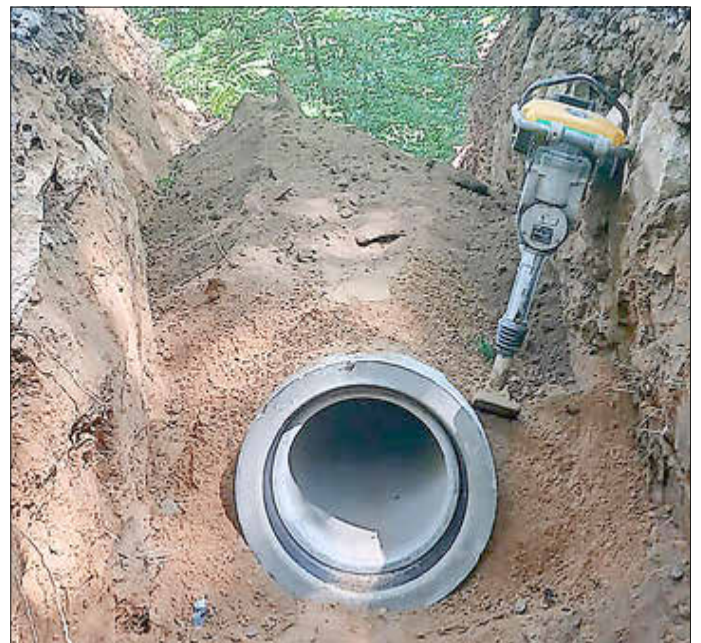
Neu eingebauter, größerer Durchlass Fotos: EUROVIA Verkehrsbau GmbH
