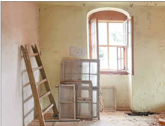
Einbau neuer Fenster im Obergeschoss
